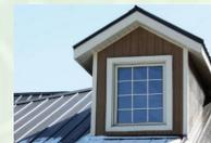
每平米重量仅有7.5公斤，可减少结构材料的使用量
