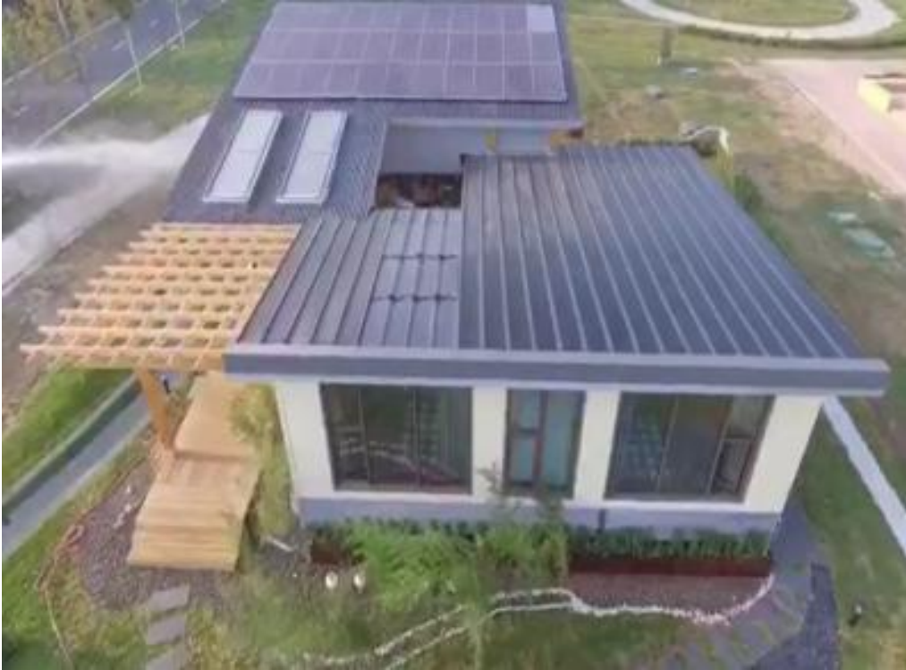
图 1-4 光伏光热得能瓦（板）工程示意图
